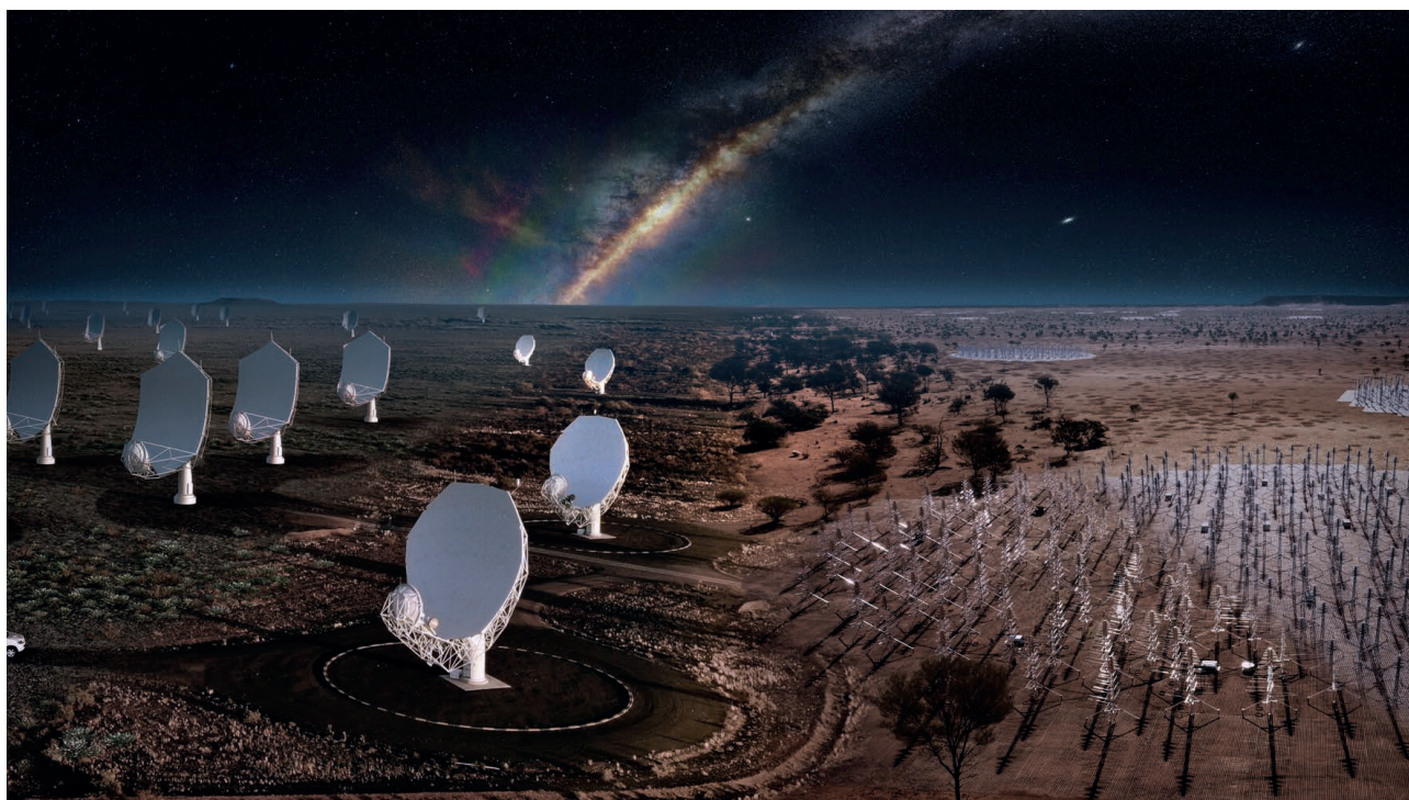
Le réseau de radiotélescope SKAO combinera les signaux de près de 100 000 antennes pour former un télescope virtuel dont l'ouverture sera égale à la distance séparant l'Afrique et l'Australie. Illustration : SKAO
