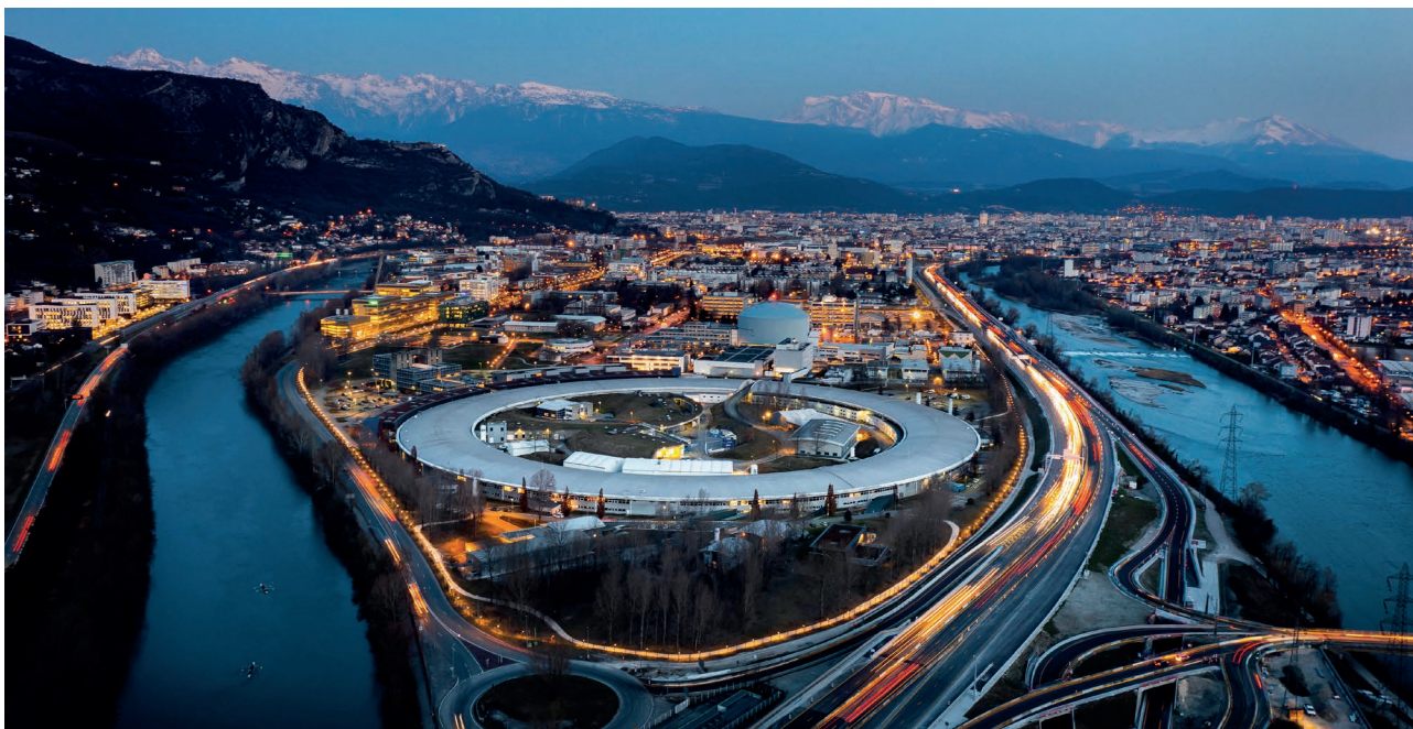
Des rayons X aux propriétés exceptionnelles sont produits à ESRF par des électrons de très haute énergie circulant dans un anneau de stockage, un tunnel circulaire de 844 m de circonférence. Photo : ESRF/VUEDICI
