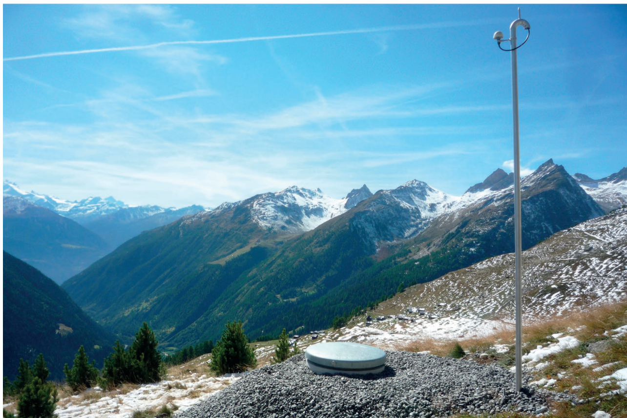
Station de mesure du Service sismologique suisse sur la Lauchneralp dans le Lötschental (VS). Les données recueillies par les réseaux sismiques de Suisse et d'Europe sont unifiés et rendus accessibles via EPOS-ERIC. EPOS propose de nombreux autres services et jeux de données dans le domaine des géosciences. Service sismologique suisse à l'EPF de Zurich.
